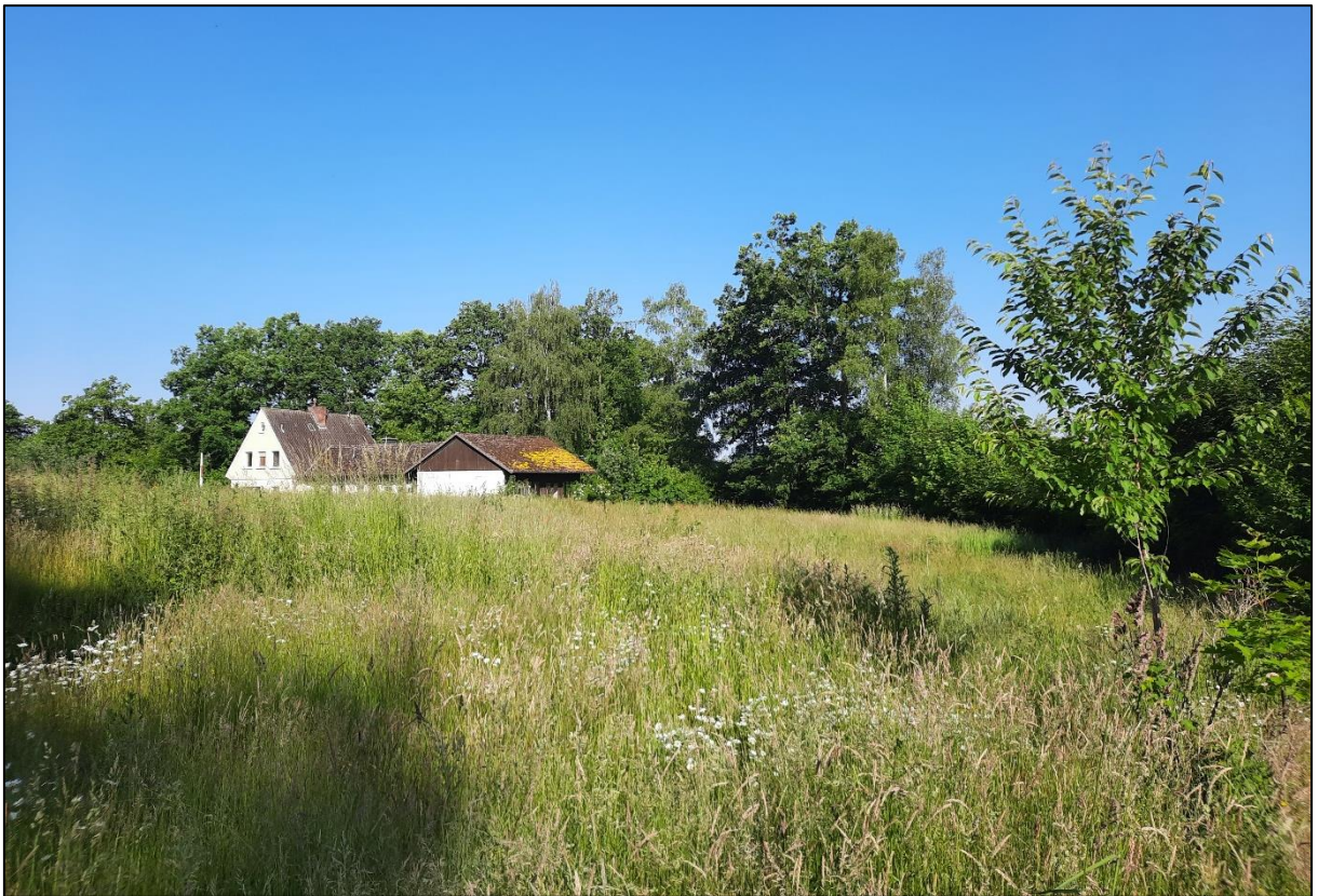
Abbildung 3: Grünfläche im Eingriffsbereich mit Blick auf das Gebäude (Blickrichtung Norden).
