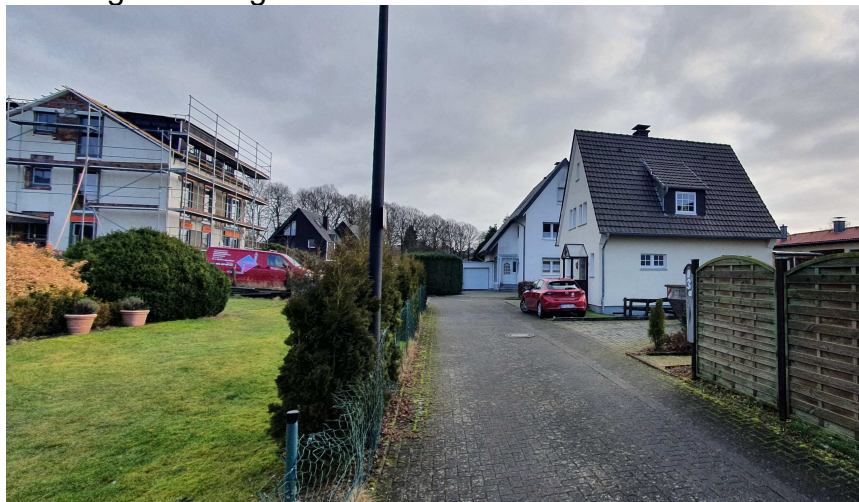
Blick in den Fährenweg nach Osten auf das Bestandsgebäude (28.01.2022)
